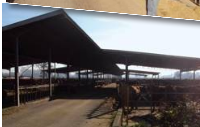
● Tre immagini dei ricoveri di più recente realizzazione, costruiti badando al risparmio ma anche alla più razionale conduzione tecnica dell'allevamento. Si tratta di strutture poco costose, semplici, ma molto funzionali: permettono a soli quattro addetti di gestire circa 1.300 animali. Oltre a poter contare su una tettoia per l'ombreggiamento estivo, durante i periodi dal clima più favorevole gli animali possono accedere a piccoli paddock.
