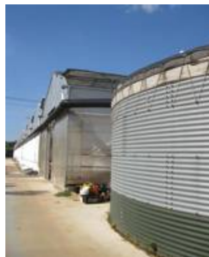
Impianto di raccolta dell'acqua piovana dalle falde dei tunnel e di convogliamento in tre cisterne della capacità di 6mila m 3 .
