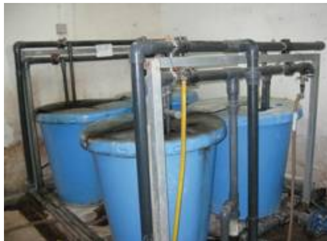
Le vasche di uno dei due impianti di fertirrigazione.
