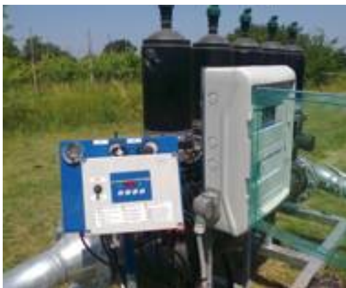
Centralina di comando del controlavaggio di un filtro automatico a dischi.
