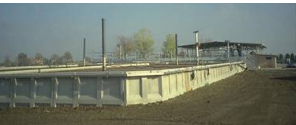
● Un impianto di trattamento di nitrificazione/denitrificazione in reattori sequenziali (SBR).
