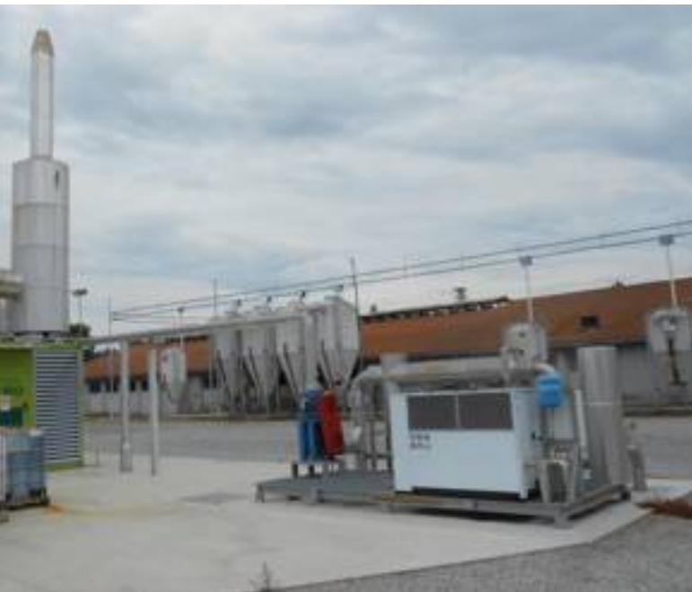
Accanto all'impianto biogas si trovano le porcilaie.
